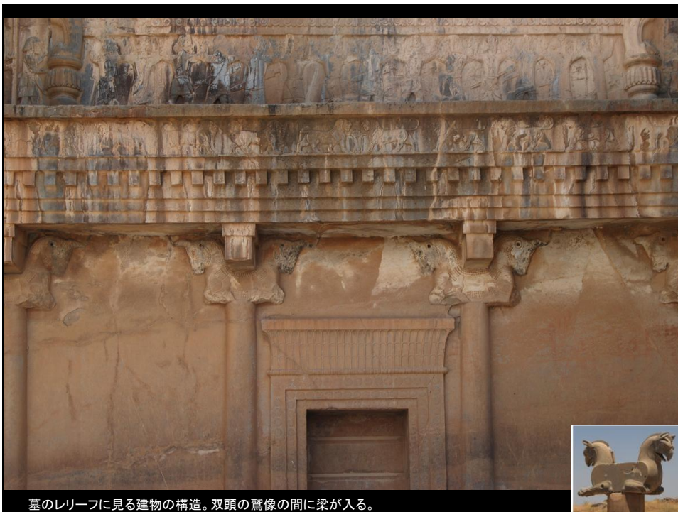
墓のレリーフに見る建物の構造。双頭の鶻像の間に梁が入る。
